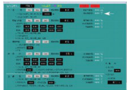
Monitoring data at actual time
